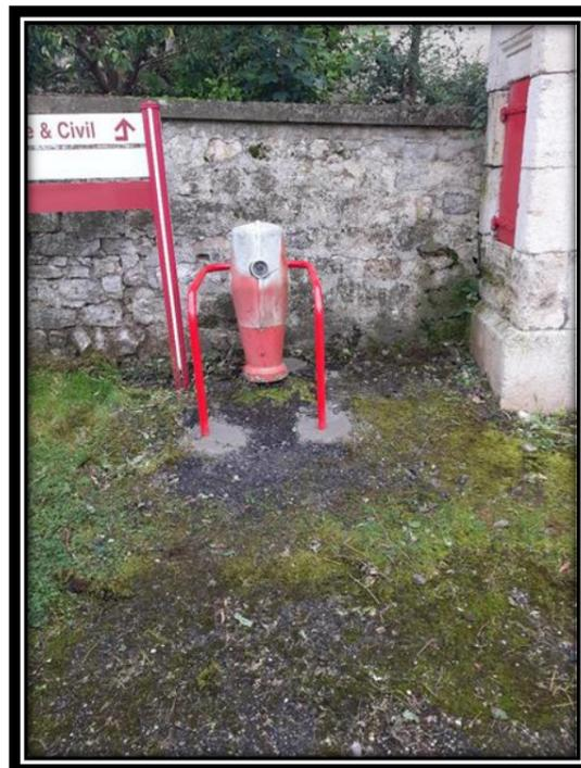
Conformément à la réglementation en vigueur nous avons installé des protections autour de certaines bornes incendies.
